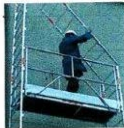
Mise en place des échelles
