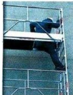
Accès à l'étage supérieur sécurisé
