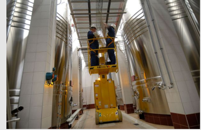
Changement d'un tube de lumière en hauteur
