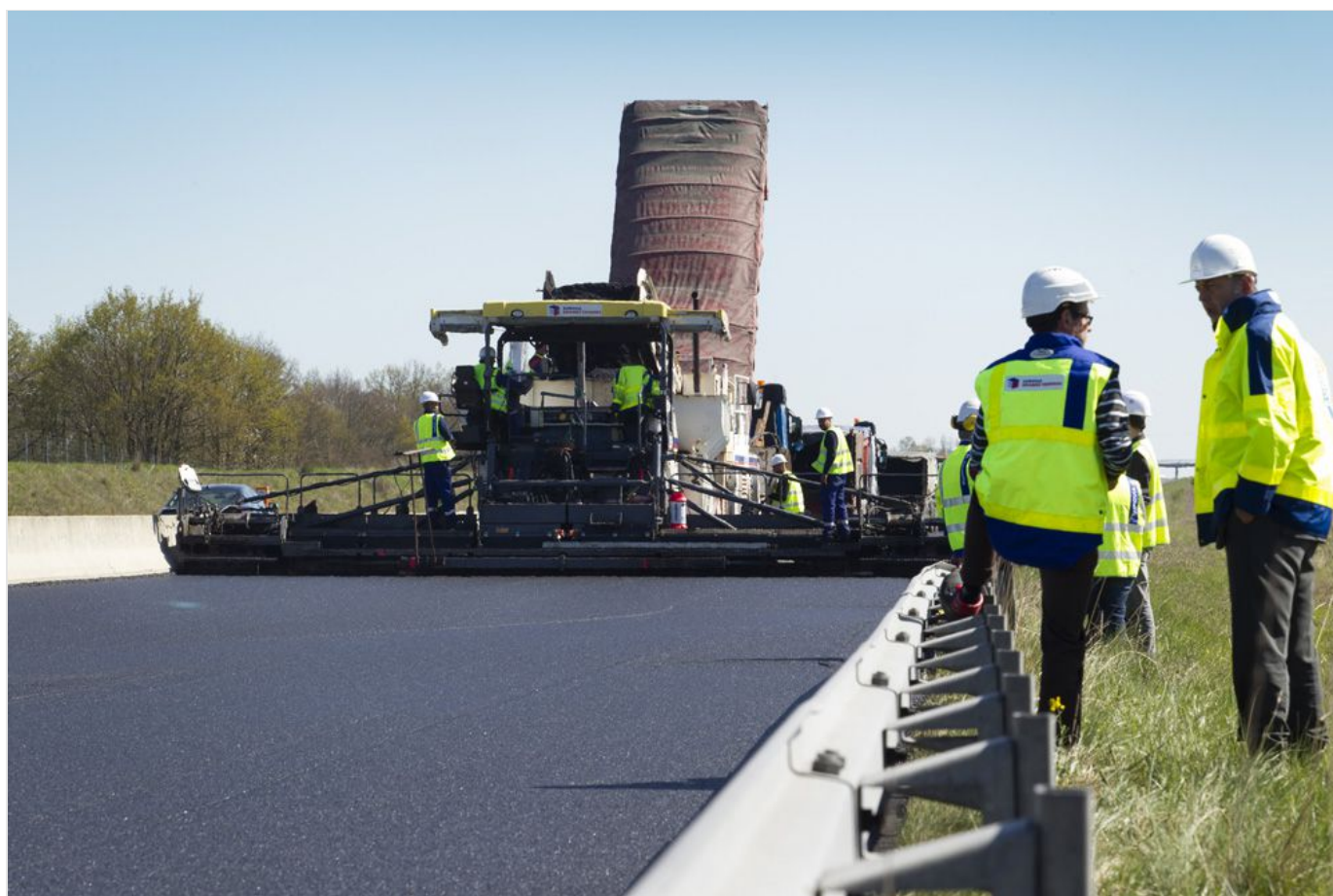
© Philippe Castano pour l'INRS Mise en œuvre d'enrobé à l'aide d'un finisseur grande largeur
