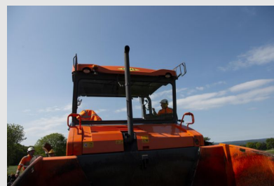
© Gael Kerbaol - INRS Application d'enrobés bitumineux à chaud avec un finisseur doté d'aspiration des fumées
