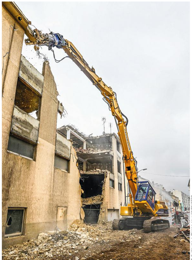
Pelleteuse équipée d'une flèche de déconstruction sur un chantier de démolition. Sa cabine est pressurisée, permettant au conducteur de l'engin de ne pas être exposé aux poussières.
