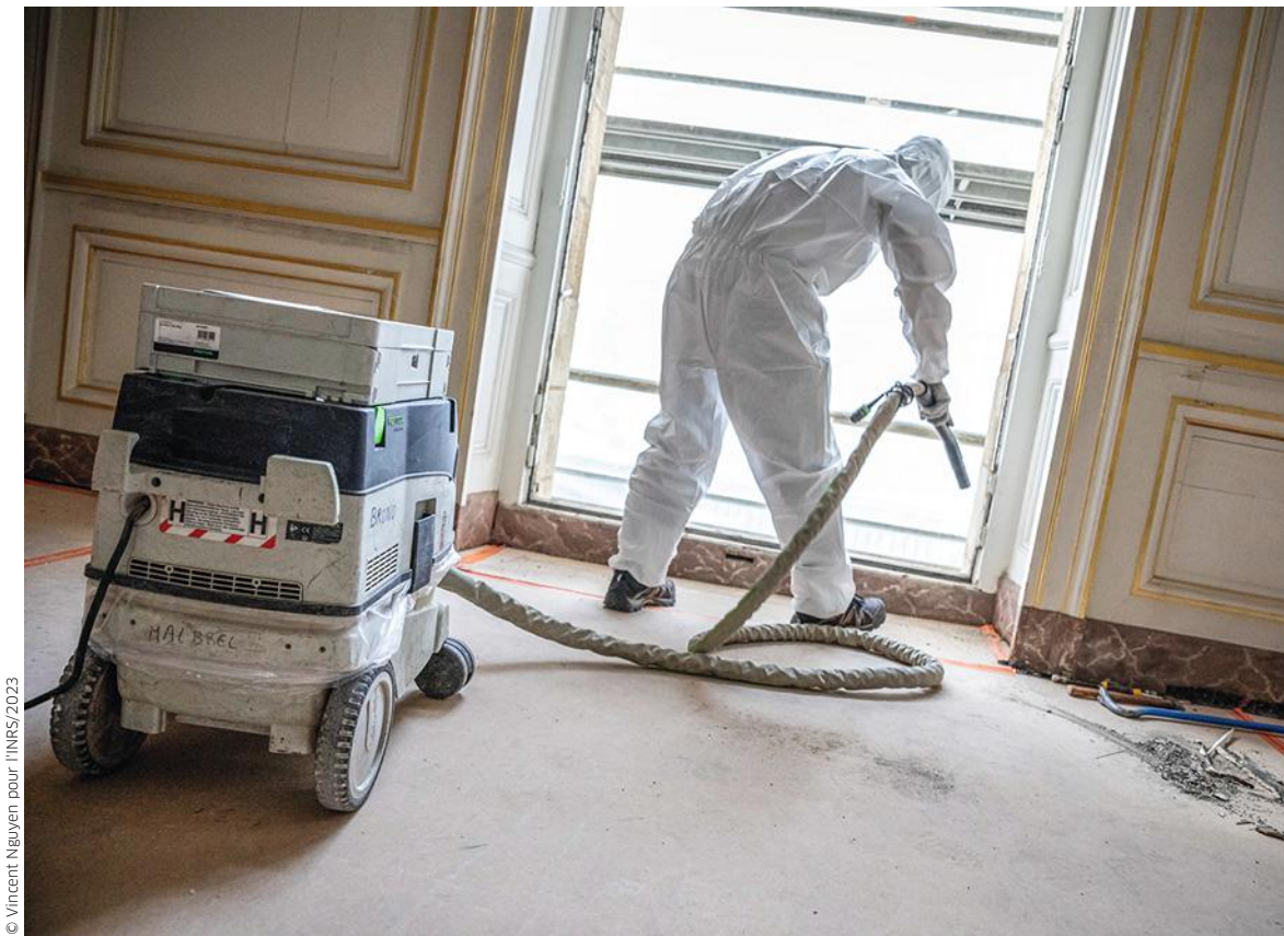
Nettoyage des huisseries à l'aide d'un aspirateur à filtration de classe H sur un chantier de rénovation d'un bâtiment ancien comportant des peintures au plomb.
