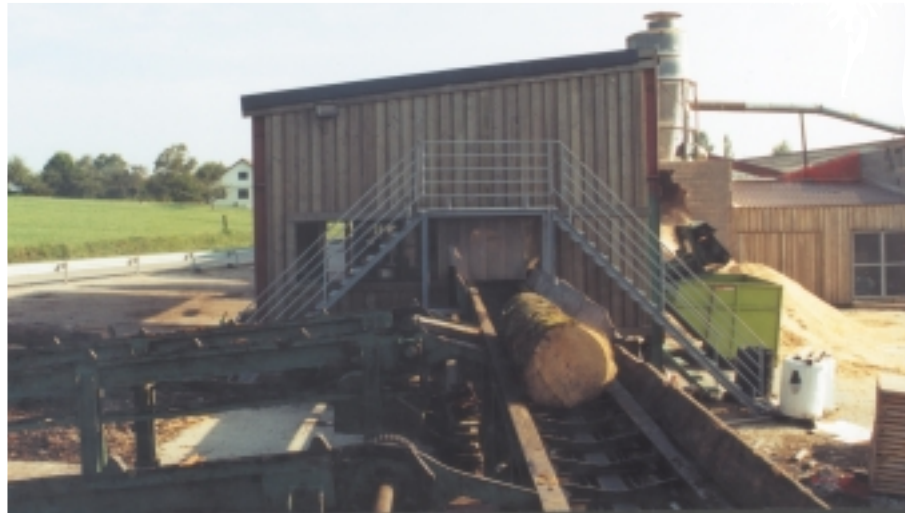
Fig. 10. Exemple de passerelle enjambant le transfert d'aménagement des billons - Example of walkway over the balk transfer conveyor
