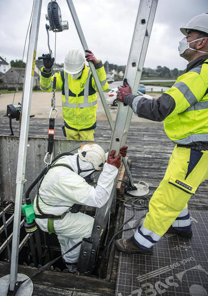
📷 L'opérateur qui descend dans les canalisations est équipé d'une combinaison intégrale, de gants épais et étanches qui remontent haut, de bottes ou de cuissardes en fonction du niveau de l'eau et d'un masque de protection respiratoire filtrant gaz et particules.
