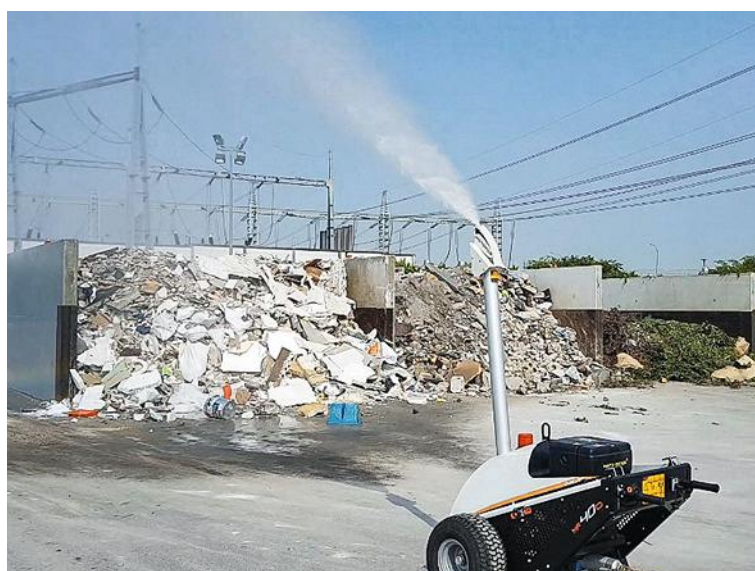
↓ FIGURE 7 Exemple de dispositif de brumisation placé au niveau d'une alvéole de gravats pour abattre les poussières lors du déchargement et de la reprise des déchets.
