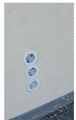
Photos 3 et 4. Le dispositif d'aspiration centralisé rejetant l'air à l'extérieur après filtration
