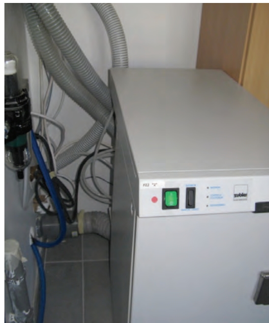
Photos 3 et 4. Le dispositif d'aspiration centralisé rejetant l'air à l'extérieur après filtration
