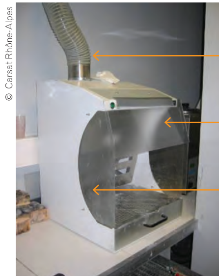
Photo 2. Le caisson aspirant après modifications
