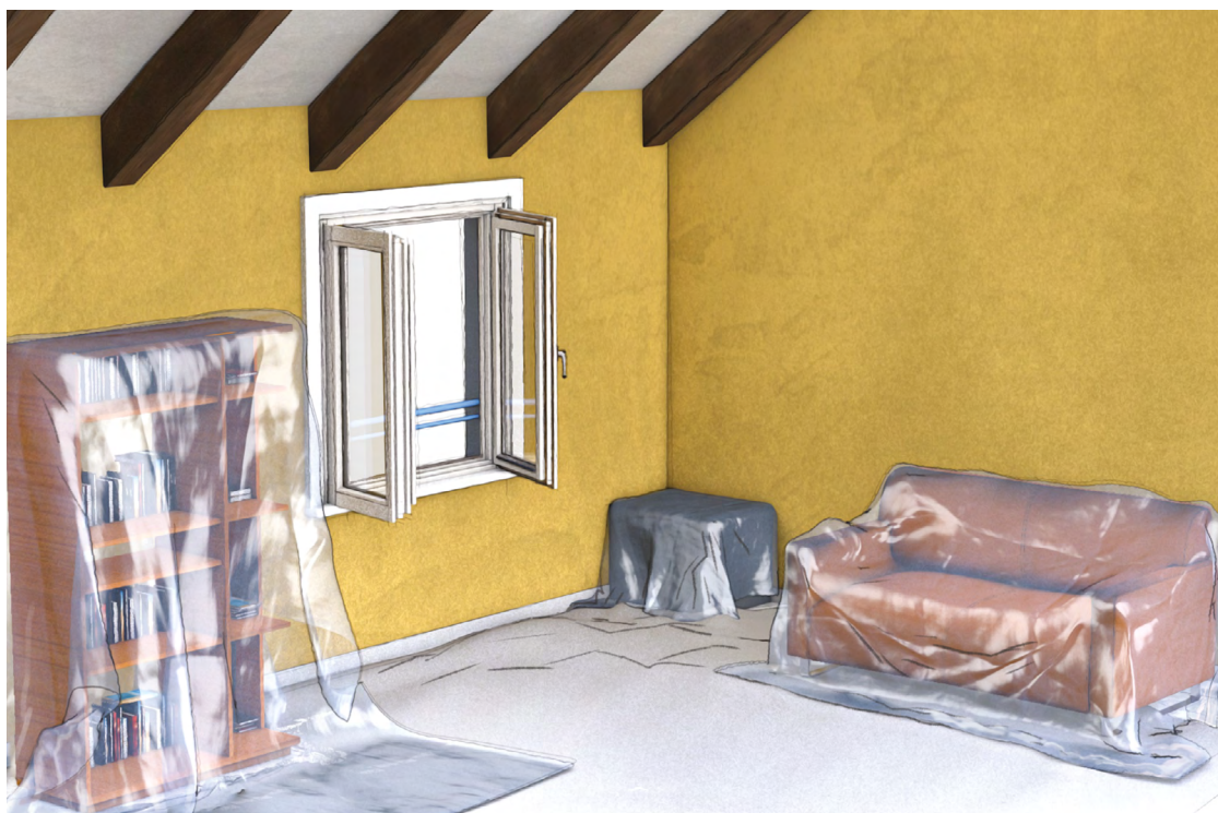
■ Figure 9. Préparation du chantier avec pose des films plastiques et création d'une ventilation naturelle
