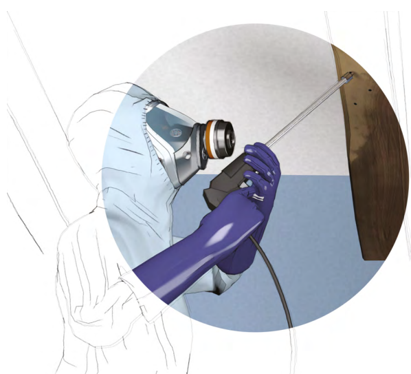
■ Figure 5. Injection du produit de traitement 2
