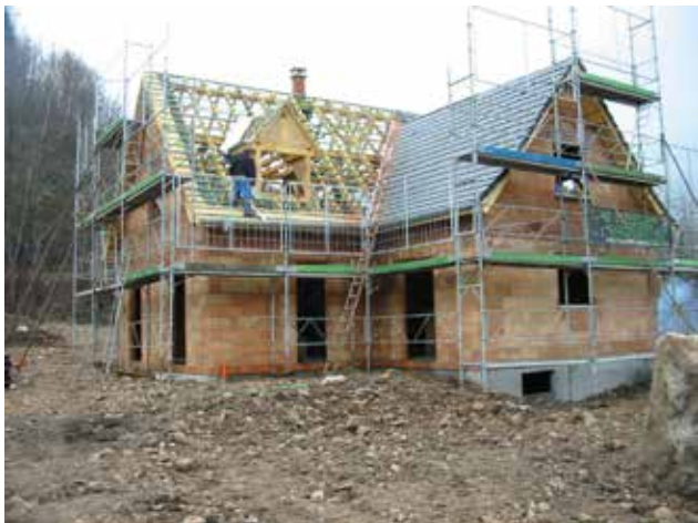
Echafaudage commun pour différents intervenants
