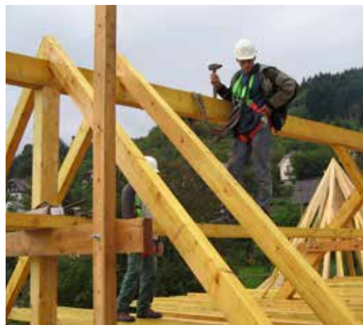
Protections collectives (filets en sous face, planchers de travail provisoire...)
