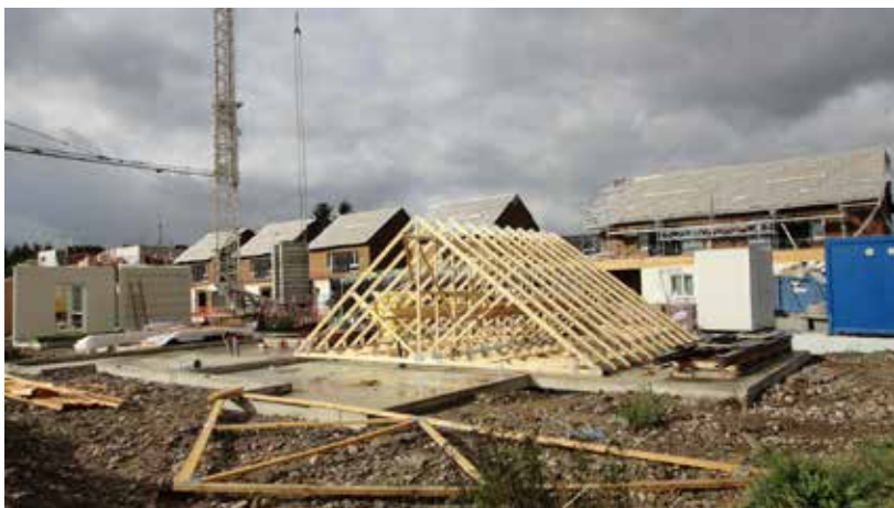
Assemblage total ou partiel au sol
