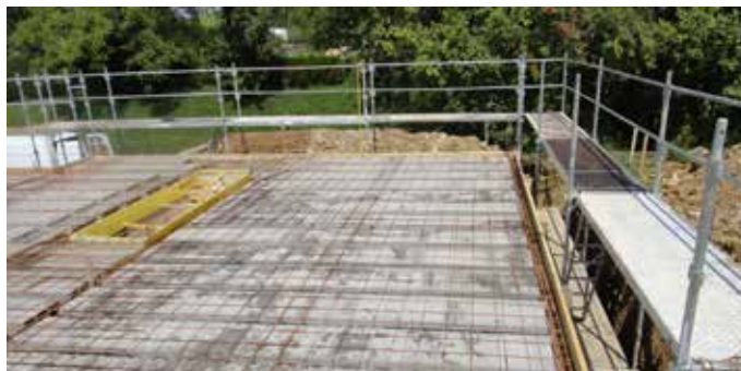
Protection collective par échafaudage de pied
