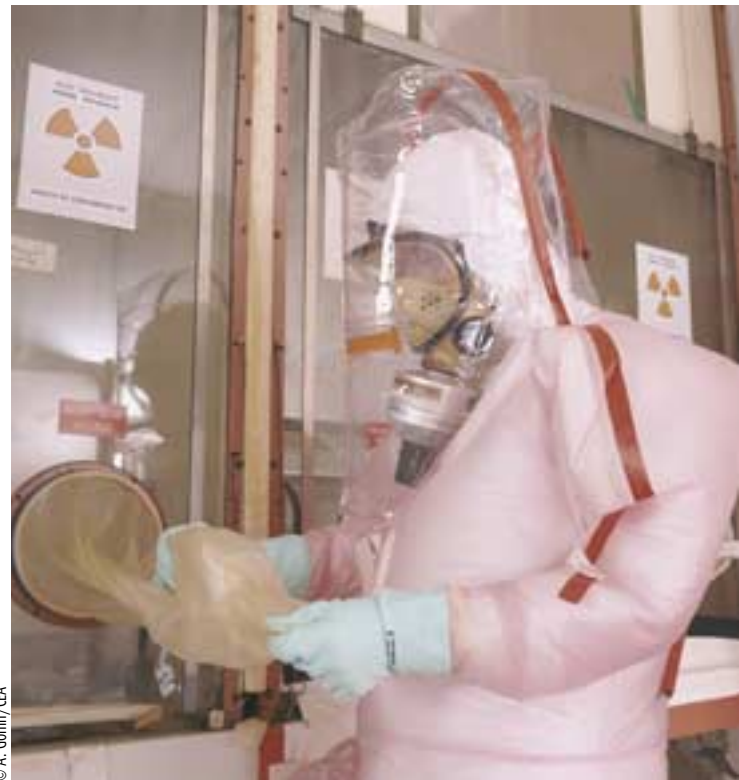
Figure 8. Chantier d'assainissement. Opérateur en tenue vinyle ventilée avec le port d'un appareil respiratoire isolant
