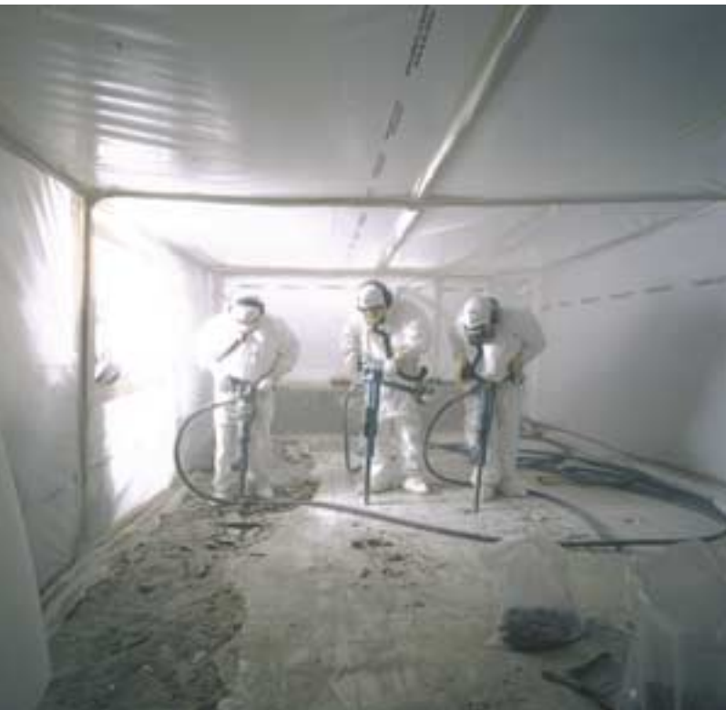
Figure 7. Démantèlement d'une installation
