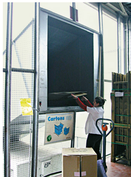
Ici, la goulotte d'introduction rend dissuasif l'accès en zone dangereuse.
