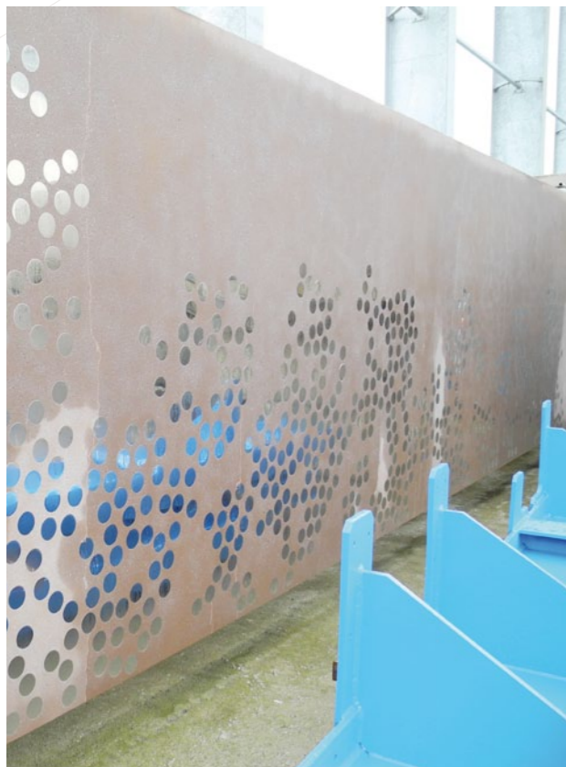
Parement extérieur préfabriqué de bâtiment en béton photocatalytique (avec inclusion de disques en inox).
