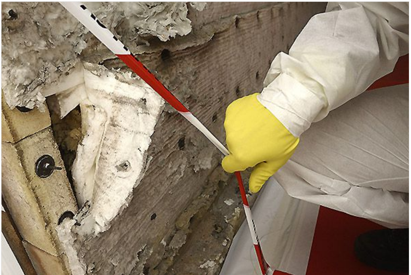
Paroi d'un four contenant des fibres céramiques réfractaires (ou FCR)
