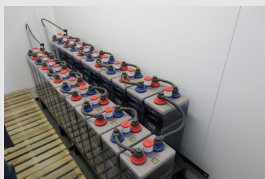
Installation de batteries électriques stationnaires
