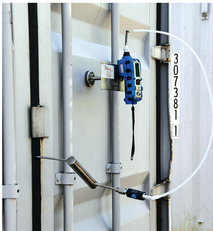
↑ FIGURE E1 Sonde d'échantillonnage insérée entre les joints des portes d'un conteneur. Le détecteur multigaz équipé d'une pompe interne est relié à la sonde via une tubulure.
