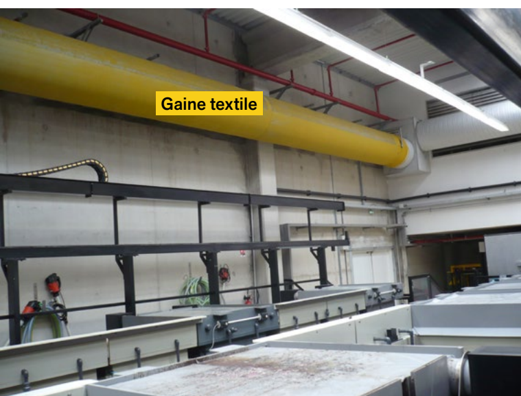
■ Photo 7. Gaine textile à diffusion totale pour la compensation d'air
