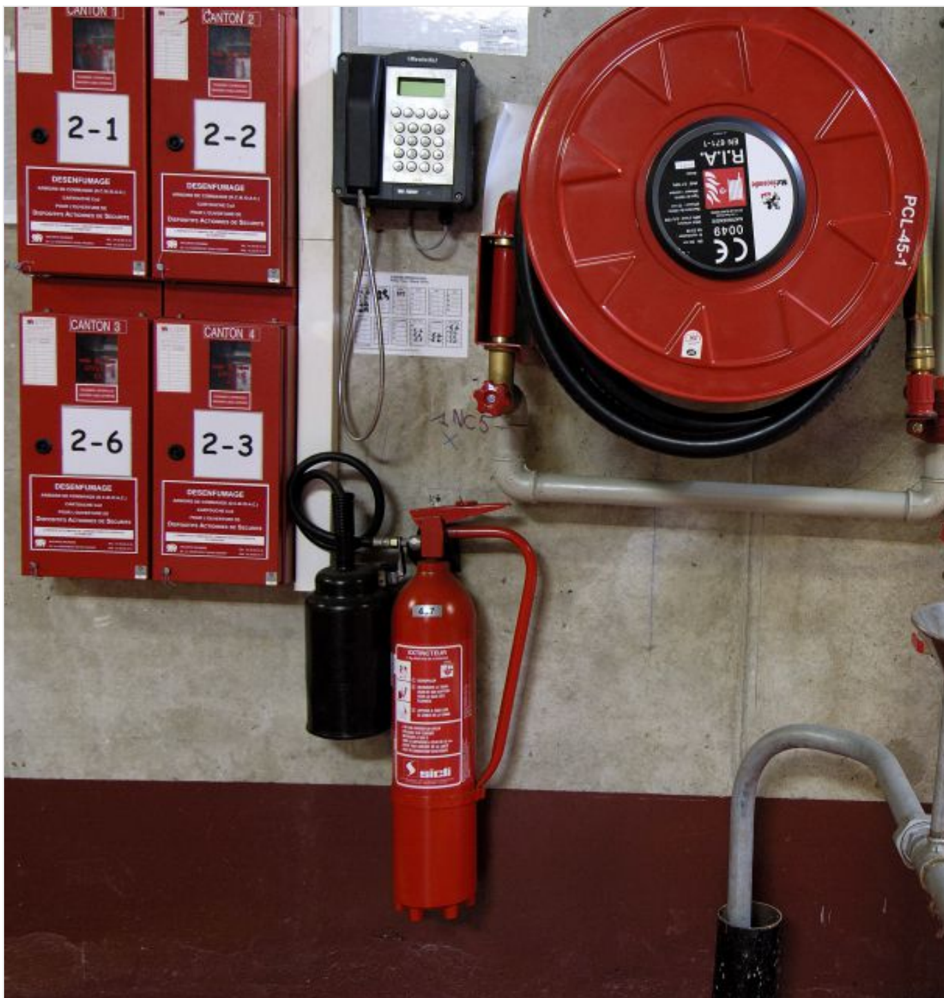
© Gaël Kerbaol/INRS - 2005 Extincteur et robinet d'incendie armé (RIA) dans une entreprise
