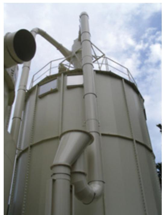
**Un silo permet le stockage des copeaux de bois utilisés comme combustible. Il est muni d'évents et d'un dispositif de découplage en cas d'explosion.**
