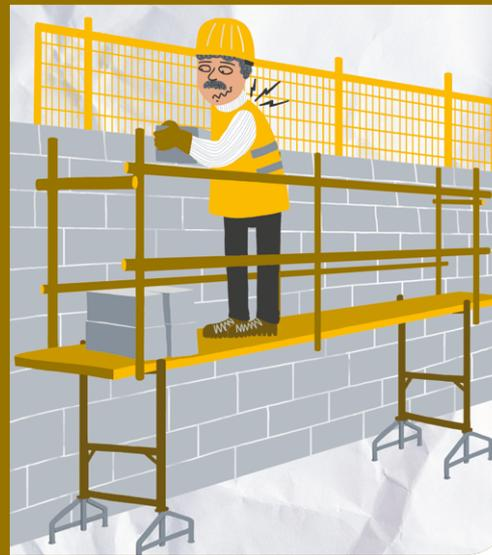
► Utilisez des tréteaux avec garde-corps sur les trois côtés, et réglage de la hauteur, pour être à la bonne hauteur de travail. Une recette à matériaux facilite l'approvisionnement et limite les chutes.
