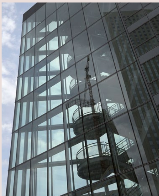
▲ Figure 6. Façade d'un immeuble en verre composé de nanoparticules de dioxyde de titane
