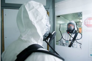
Opérateur équipé de ses équipements de protection individuelle à l'entrée d'un sas sur un chantier de désamiantage
