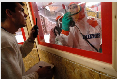
Communication par radio d'un opérateur avec le chef de poste à travers la fenêtre de surveillance d'un chantier de désamiantage
