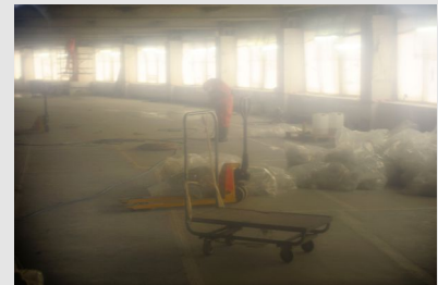
Vue d'un chantier de désamiantage à travers la fenêtre de surveillance
