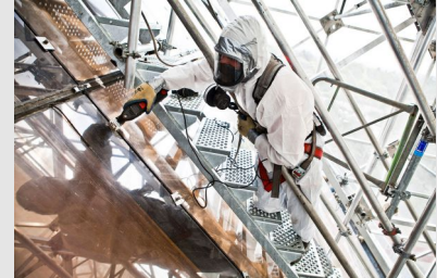
Travail d'un opérateur sur un échafaudage pour le désamiantage d'une verrière
