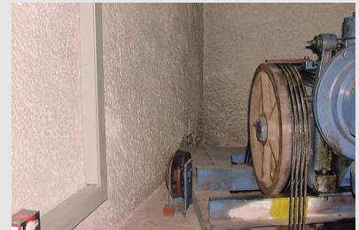
Machinerie d'ascenseur susceptible de contenir des matériaux amiantés (flocage, freins...)
