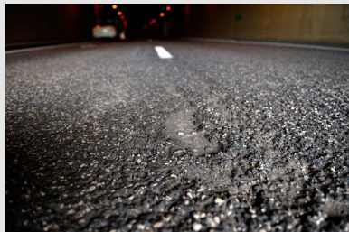
Revêtement goudronné d'une chaussée contenant de l'amiante
