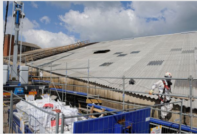
Vue d'ensemble d'un chantier de retrait d'une toiture amiantée, avec le stockage intermédiaire des déchets au premier plan
