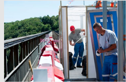
Construction d'une installation de décontamination sur un chantier de désamiantage sur un viaduc
