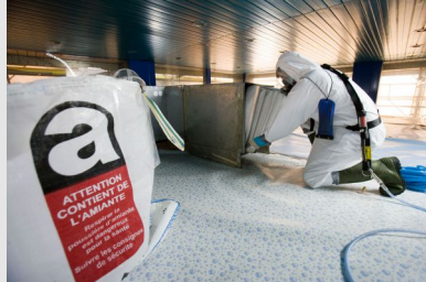
Travail d'un opérateur équipé de ses équipements de protection individuelle sur un chantier de désamiantage
