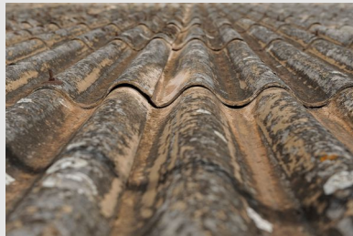
Toiture amiantée en fibrociment
