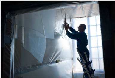
Pose de plastique pour délimiter une zone de confinement sur un chantier de retrait d'amiante
